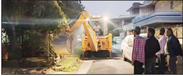
अवैध निर्माण को हटाने हुए एमसी के कर्मचारी।
