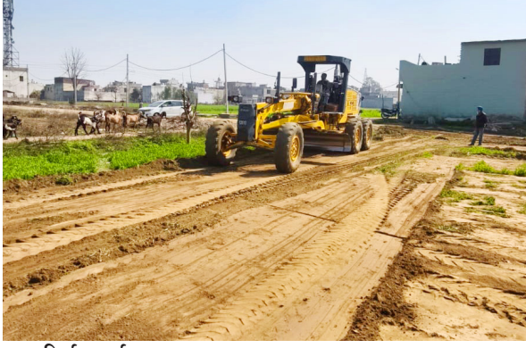
सड़क निर्माण कार्य चलता हुआ।
